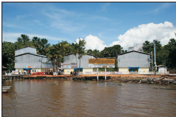
Figura-4.18. Fábricas de gelo e de óleo, e usina elétrica do “Projeto Marajó”, Breves, PA.
