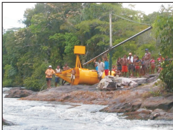
Figura-4.7. Montagem da turbina em Cavanã, Rio Maracá, Mazagão, AP. Fonte: Barreto, (2007f); Brasil Jr. & Els (2007).
