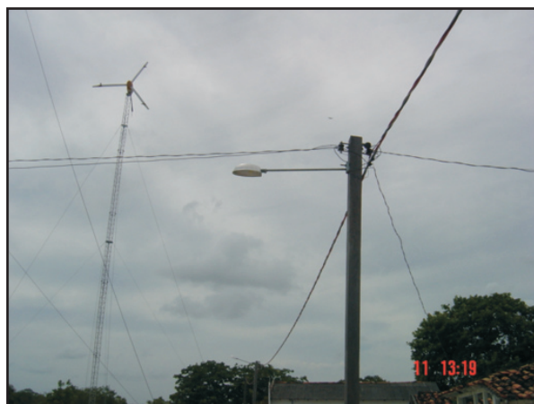
Figura-4.20. Rede multiplexada e turbina eólica em Tamaruteua, PA. Fonte: Barreto (2007c).
