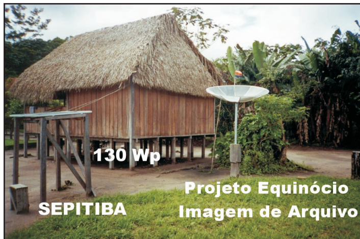
Figura-3.22. Recepção de TV em Centro Comunitário com 130 Wpico e 12 volts.
