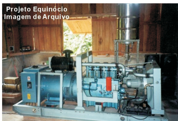
Figura-3.28. Gerador Multicomcombustível de 115 kW, instalado no Roque em 1998. Fonte: Di Lascio (2004a).
