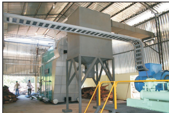
Figura-4.19. Caldeira, turbina e gerador do “Projeto Marajó”, Breves, PA.
