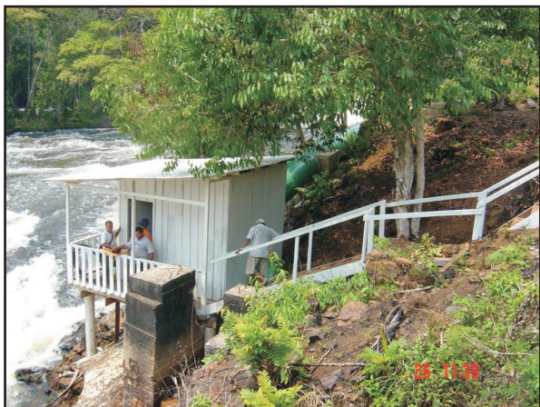
Figura-4.9. Tomada d'água, Cachoeira do Aruã, rio Arapiúms, Pará. Fonte: Barreto (2007c).
