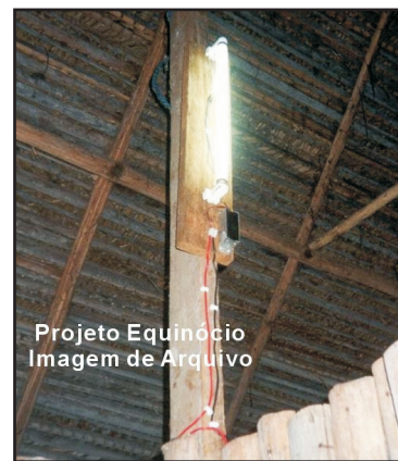
Figura-3.25. Luminárias rústicas de 12W e 15W, mais adequadas para o clima da Amazônia. Fonte: ibidem.
