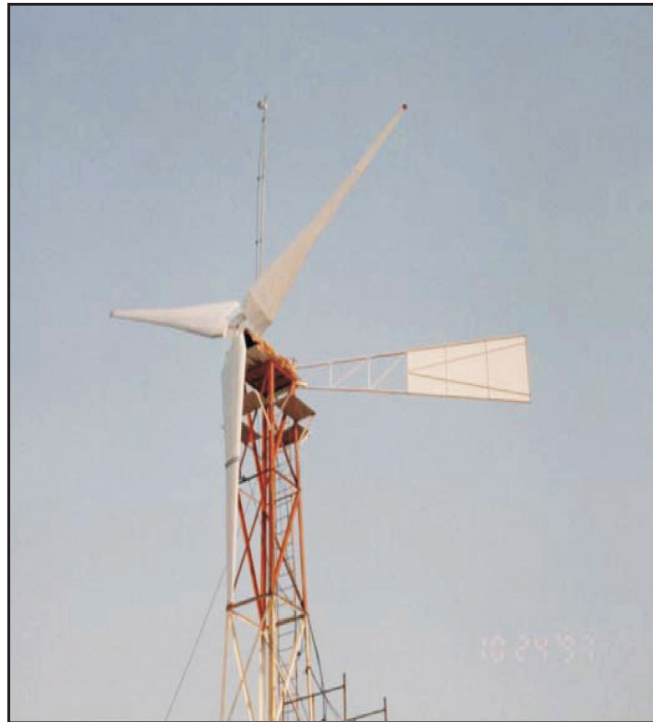
Figura-3.16. Turbina de 15 kW do sistema eólico de Praia Grande, PA. Fonte: Vale (2000).
