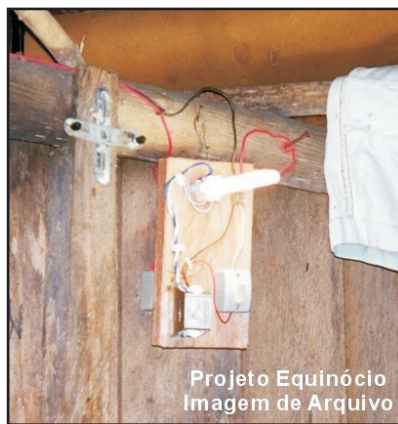
Figura-3.25. Luminárias rústicas de 12W e 15W, mais adequadas para o clima da Amazônia. Fonte: ibidem.
