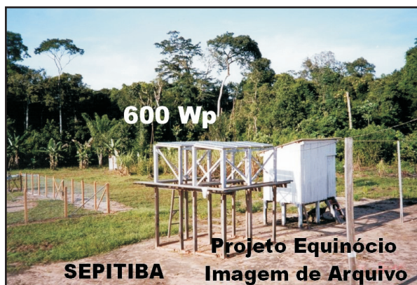
Figura-3.23. Sistema fotovoltaico de 600 Wpico e o congelador de Sepitiba.
