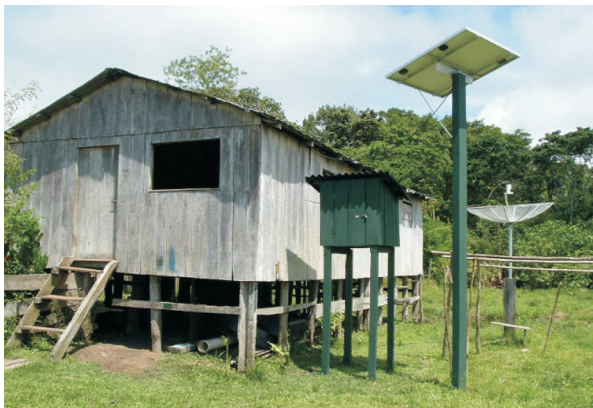
Figura-3.20. Altura e inclinação excessivas dos painéis fotovoltaicos de São Francisco do Aiuçá. Fonte: Zilles (2007).
